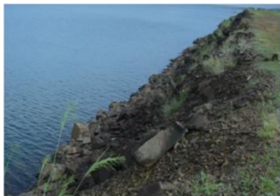
a) Protección con rip-rap
