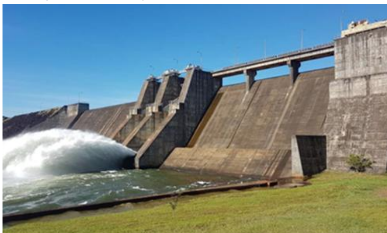
Imagen 7. Presa de gravedad
