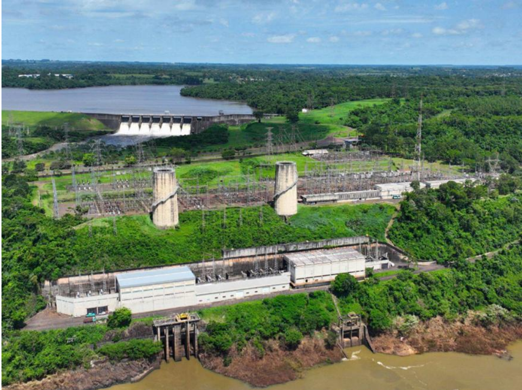
Imagen 2. Vista aérea de la Central Hidroeléctrica Acaray con la Presa y Embalse Acaray al fondo
